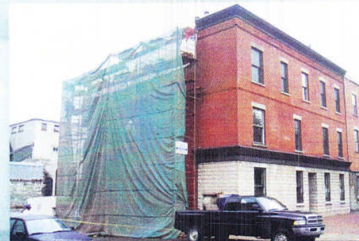
SYNDICAT DES COPROPRIÉTAIRES DU 2030 ST-ANTOINE OUEST Reconstruction des sections des murs de briques avec des ventres de bœuf
