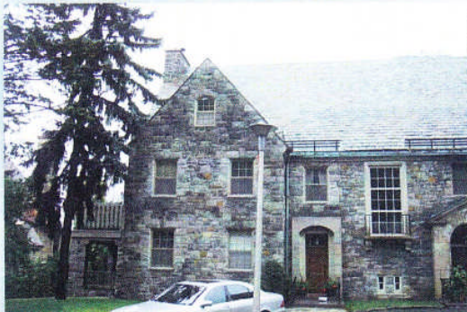
RÉSIDENCE PRIVÉE DU CONSUL DE LA BELGIQUE À MONTRÉAL Réfection professionnelle des joints de mortier, injections des pierres fissurées, imperméabilisation des murs de pierres.
