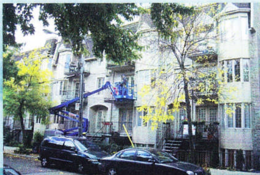
SYNDICAT DE LA COPROPRIÉTÉ 4478 LAVAL Restauration professionnelle et ponctuelle des joints de mortier défectueux
